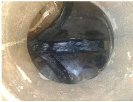
Cámara Boca en su interior se observan dos canales que ingresan los efluentes, uno de ventilación y el de descarga
