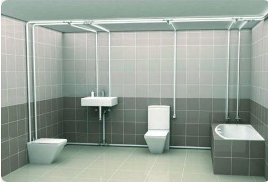
En la revisión general debe comprobarse el estado del aislamiento y señalización de la red de agua, la estanquidad de las uniones y juntas, y el correcto funcionamiento de las llaves de paso y válvulas, verificando la posibilidad de cierre total o parcial de la red.
